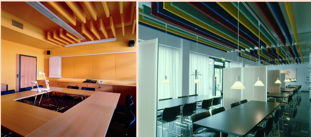
Abbildung 47: Deckenbaffles aus Holz (Foto: Paul Ott, Architektur: Ernst Giselbrecht + Partner).
