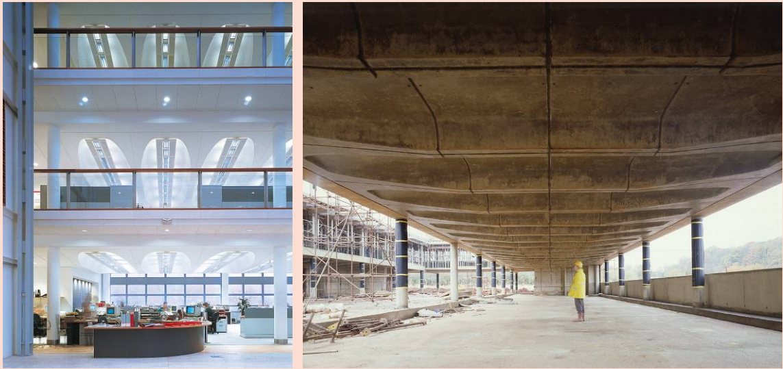
Abbildung 19: Strukturierte Betondecke im Powergen-Bürogebäude in Coventry, England. Links fertiges Gebäude, rechts als Baustelle. Architektur: Bennetts Associates Architects. (Fotos: Peter Cook).
