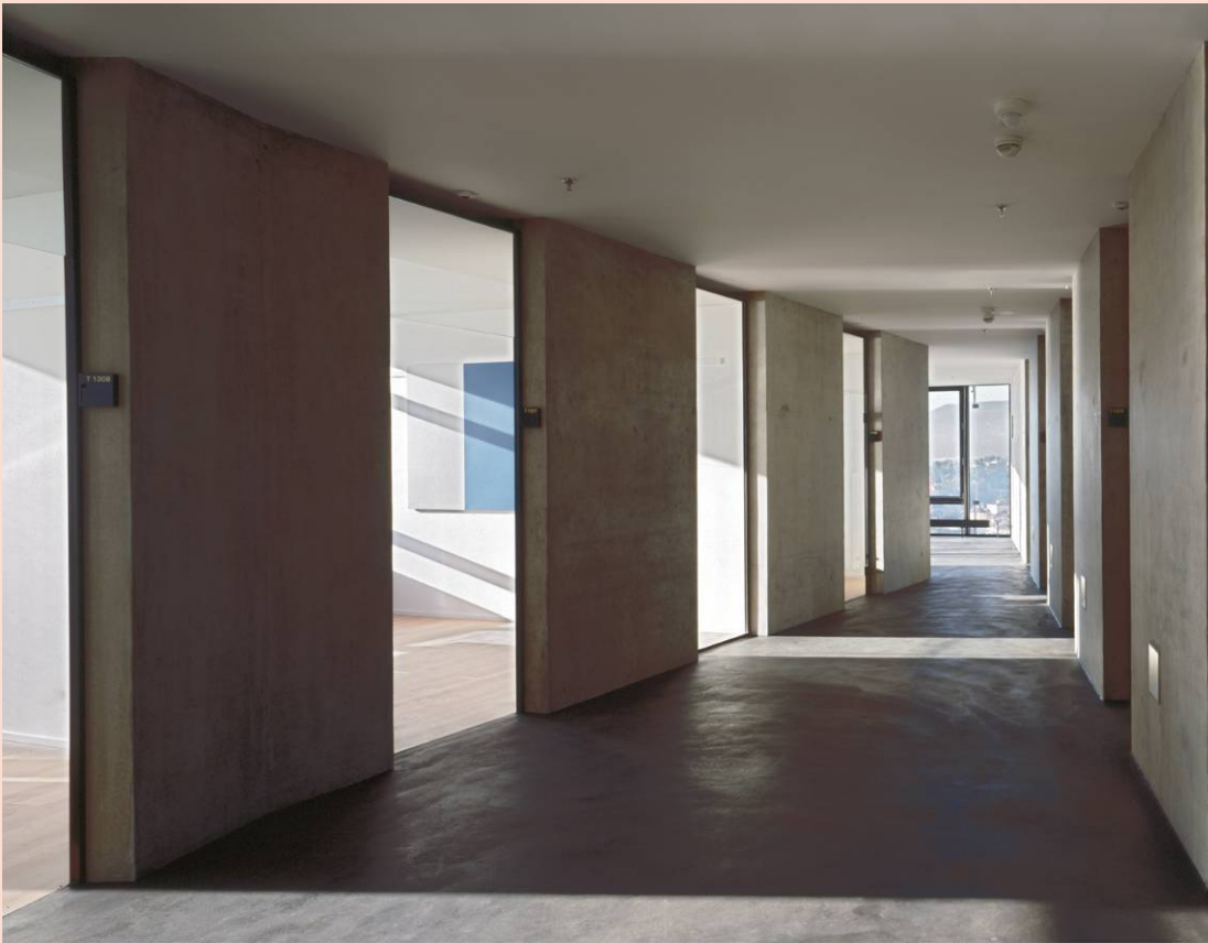
Abbildung 26: Massive Flurtrennwände im Neubau-Turm des Bundesamtes für Statistik, Neuchâtel, Schweiz. (Architektur: Bauart Architekten und Planer AG, Bern. Foto: Ruedi Walti, Basel)
