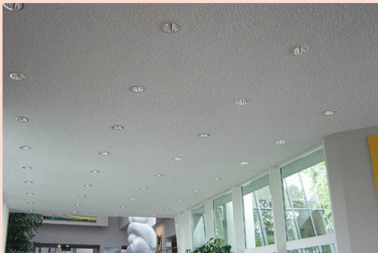
Abbildung 49: Akustikputz (Foto: Akustik und Malerei Fink 2 ).
