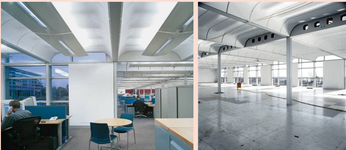
Abbildung 20: Strukturierte Betondecke in der Wessex Water Operations Centre in Bath, England. Links fertiges Gebäude, rechts als Baustelle. Architektur: Bennetts Associates Architects. (Fotos: Peter Cook).
