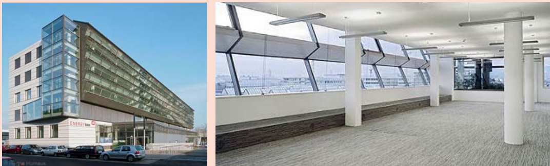
Abbildung 70: ENERGYbase in Wien. (Architektur: pos architekten; Fotos: Hertha Hurnaus)
