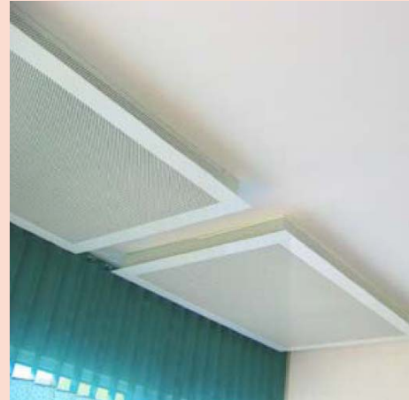
Abbildung 43: Akustikplatte an der Decke (Quelle: Renz GmbH).
