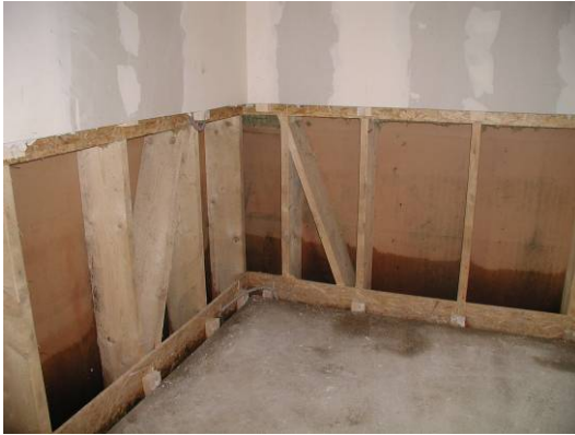
Abbildung 24: Austrocknung einer Holzsteherwand (Quelle: BTI)
