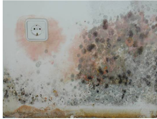
Abbildung 25: Schimmelbildung (Quelle: BTI)
